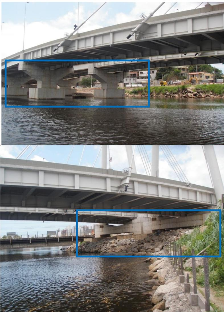
Figura 14 - Nova Ponte da Passagem. Em azul são mostradas as estruturas de sustentação da ponte que foram instaladas.
