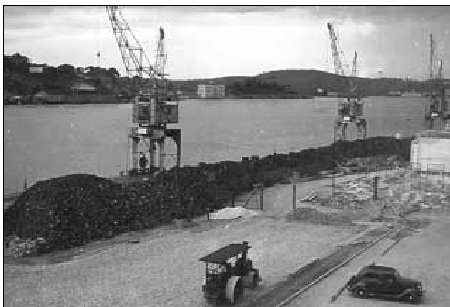
Figura 5: Início das obras de construção do Porto de Vitória, década de 20. Fonte: Acervo PMV.
